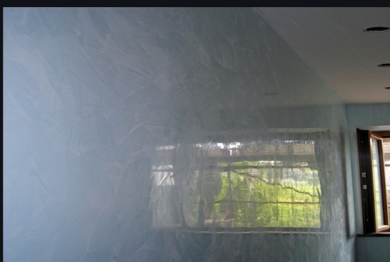
Stucco spatolato • finitura decorativa.
