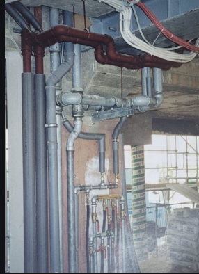
Montanti e percorsi verticali.
