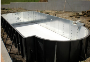
Vasca in fase di realizzazione.
