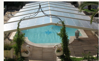
Copertura e protezione.
