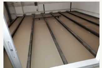
Struttura di controsoffitto e carpenteria.
