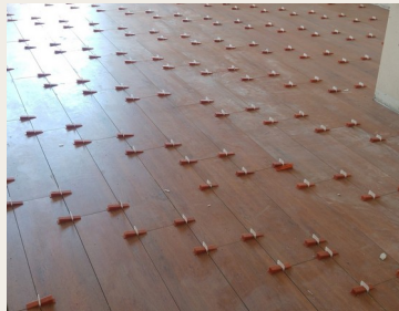
Pavimentazione • fase di posa.
