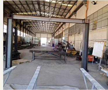
03 • Struttura in avanzamento.
