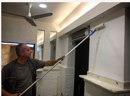
Presenza operativa quando è utile al risultato.
