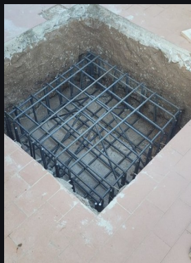
1 · Excavación y preparación.
