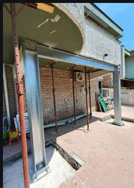
3 · Montaje de estructura.
