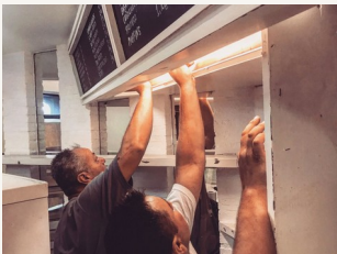
Intervención directa durante el acondicionamiento.
