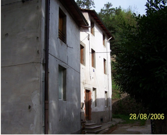
ANTES • edificio por reformar.
