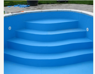
Detalle de escalera terminada.
