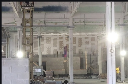
Gran superficie en fase de ejecución y coordinación.
