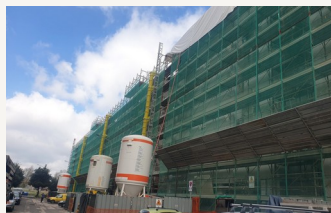
Fachadas, trabajos metálicos y pintura.
