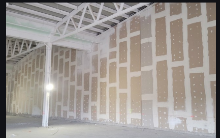
Obras interiores, instalaciones y acabados en entorno retail.
