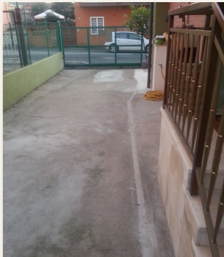
Pavimento exterior - antes.
