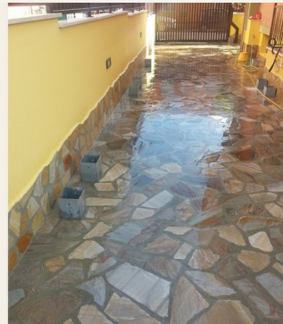
Pavimento exterior - después.
