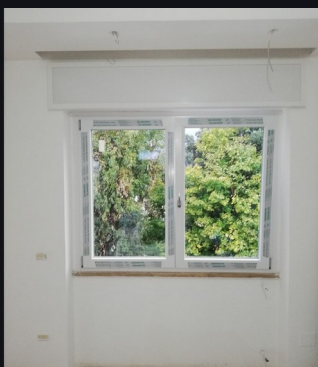
Cerramiento + pladur · integración de trabajos.
