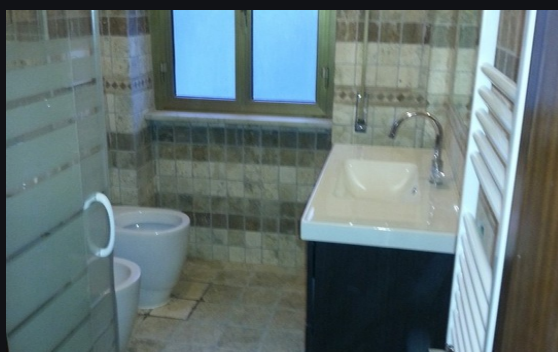
Colleferro · revestimientos y acabados.
