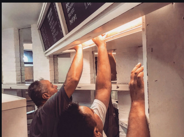
Madrid: intervención directa durante el acondicionamiento de un local comercial.
