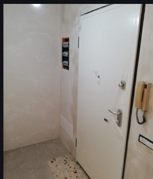
Puerta de entrada · sustitución y acabado.
